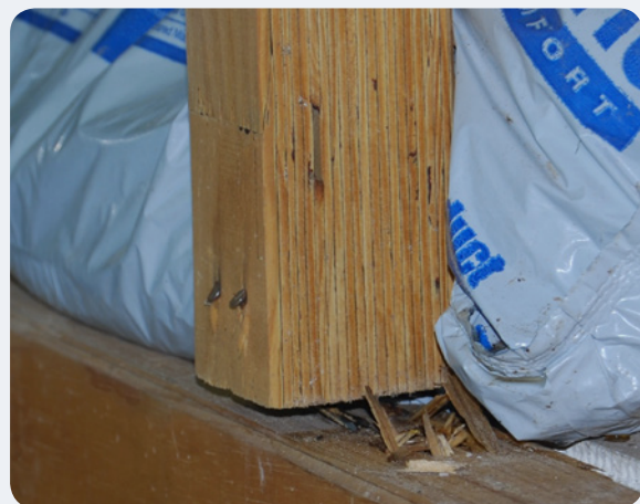
(d) Strut-to-top-plate connection
